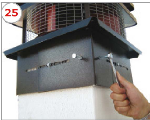
Repetir la operación para los dos bulones.
